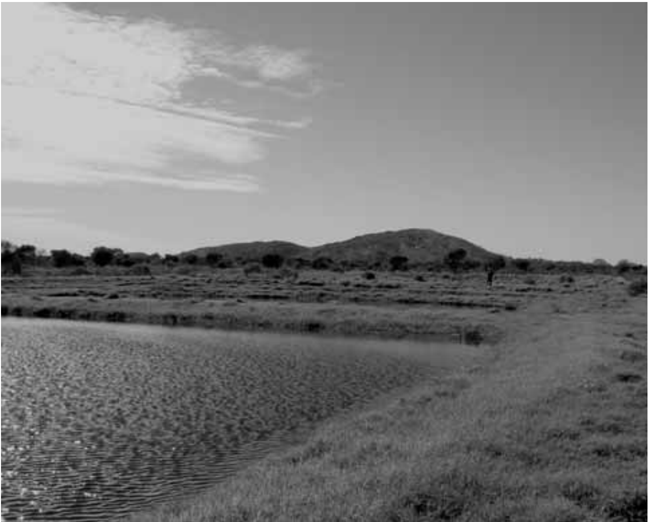
PAPUNYA SEWERAGE POND
